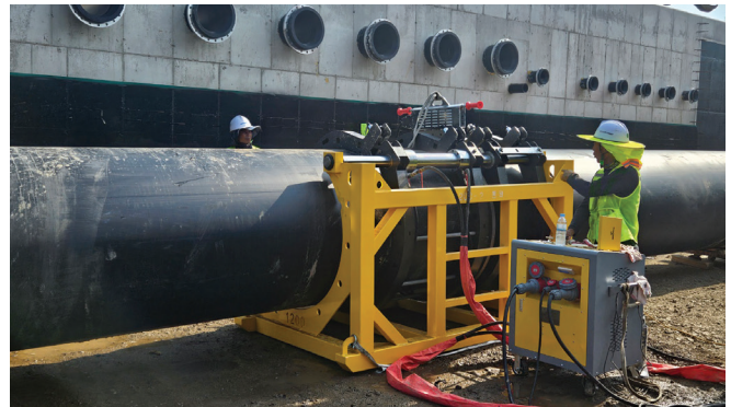
PE pipe joining
